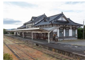
改修前の旧大社線大社駅
